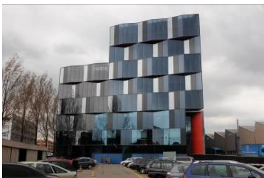
Abbildung 11: Fassadenintegriertes PV-System (Quelle: Fa. Ertex Solar)
