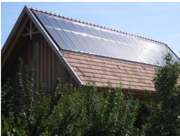
Abbildung 10: Bestehendes Dach einer Scheune, nachgerüstet mit PV-Modulen (Quelle: Fa. Ertex Solar)
