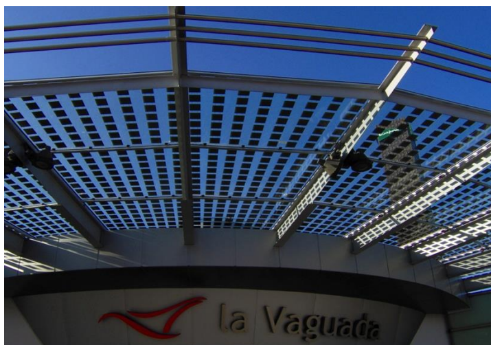
Abbildung 9: Halbtransparente Solarmodule für die Verschattung in einem Vordach (Quelle: Fa. Ertex Solar)
